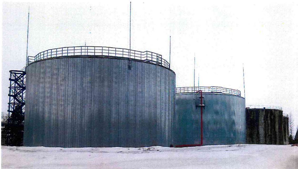
Рис.3 Резервуары хранения мазута
