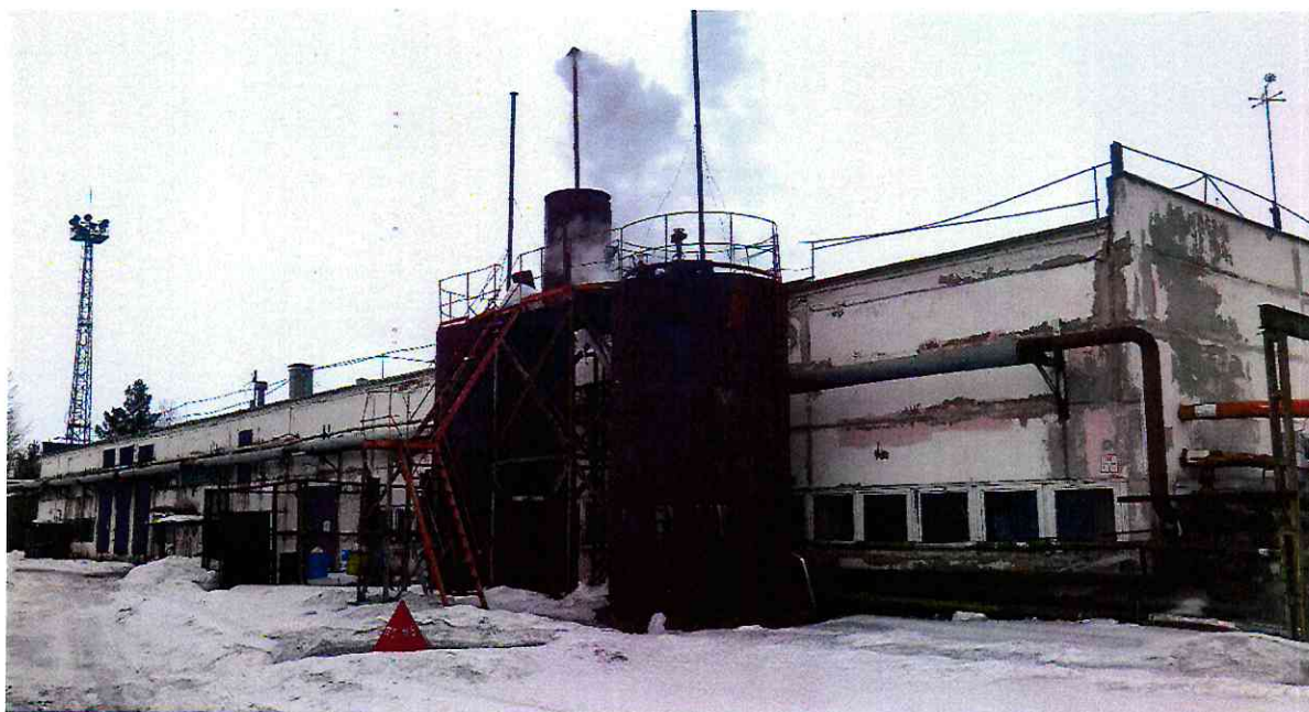
Рис.2 Здание мазутонасосной станции
