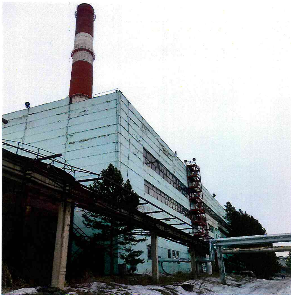
Рис.1 Общий вид котельной
