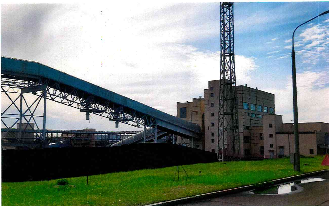
Рис.3 Склад угля. Здание дробильного корпуса.
