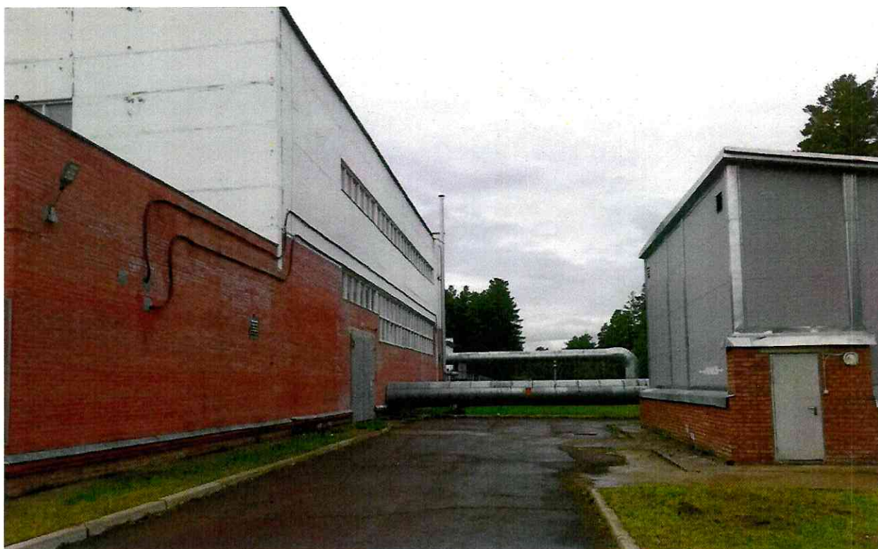
Рис.4 Общий вид здания подкачивающей насосной станции.
