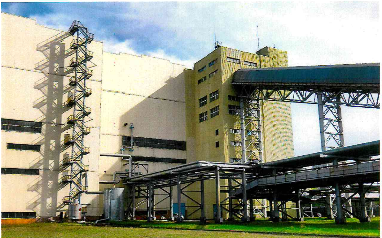
Рис.2 Постоянный торец паровой котельной.
