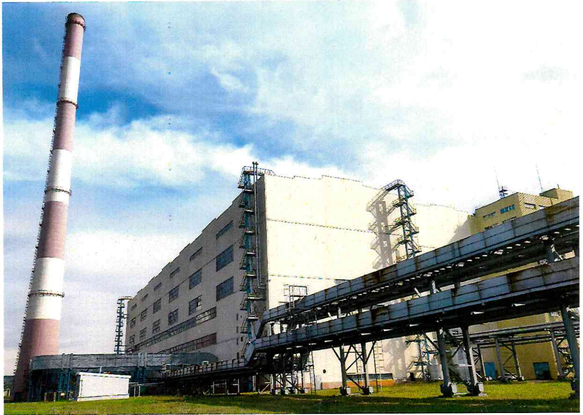
Рис.1 Общий вид паровой котельной.
